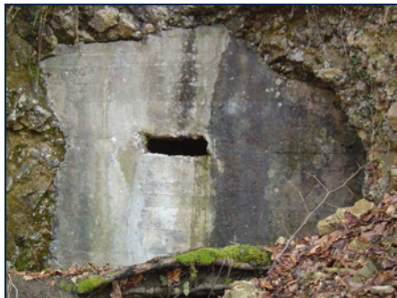
Ein kleiner Durchlass ermöglicht den Fledermäusen die Nutzung des Stollens als Überwinterungsstandort (Foto: Hansruedi Möhl).
