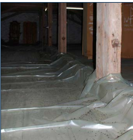
Ausgelegte Plastikplanen vereinfachen zukünftig die Reinigung. (Foto: Agnes Schümperlin)
